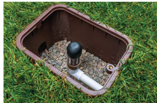
Entlüftungs-/Druckausgleichsventil installiert
