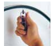
Einsetzen eines Blindstopfens
